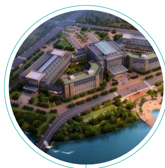
连云港大陆桥会展中心 总建筑面积约 14 万平方米
